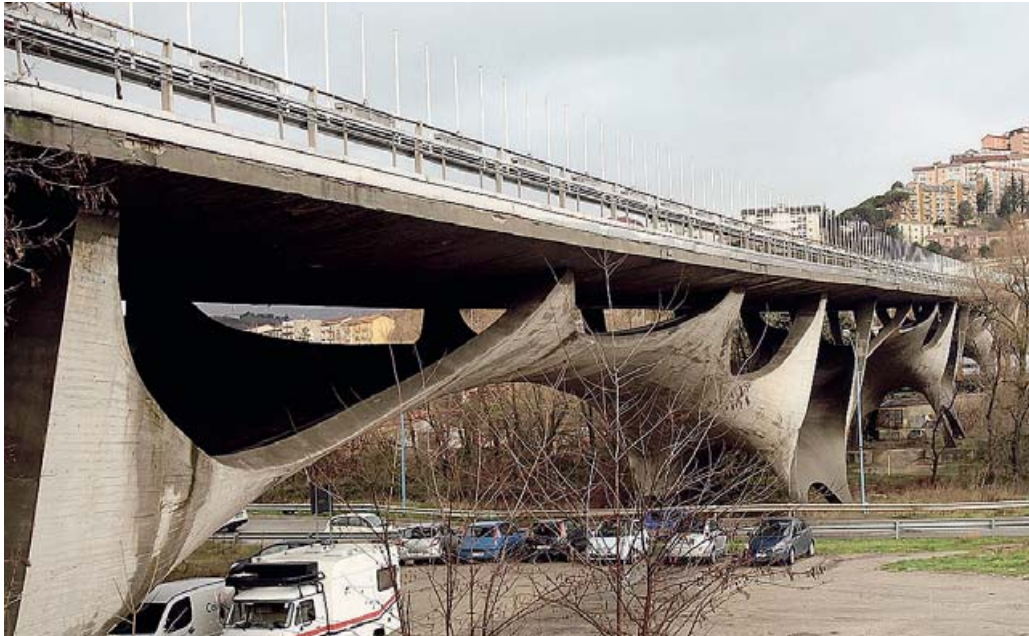
VIADOTTO Il ponte Musmeci, uno dei simboli del capoluogo [foto Tony Vece]
