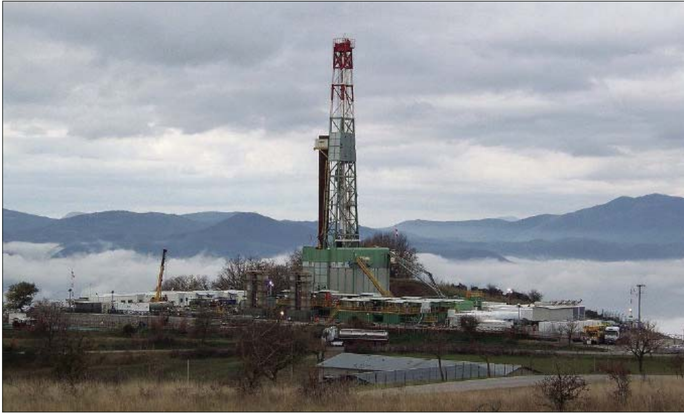
Un pozzo in perforazione a Viggiano
