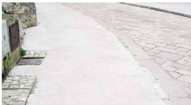
CEMENTO NEI SASSI Impossibili quei marciapiedi in via Sant'Antonio Abate e via Madonna delle Virtù
