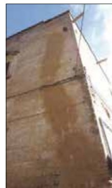
L'immobile di via Casalnuovo
