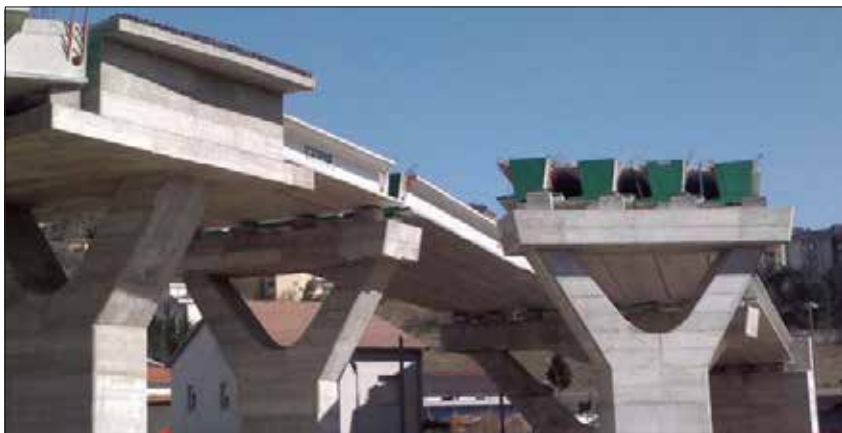
Il cantiere del Gallitello a Potenza
