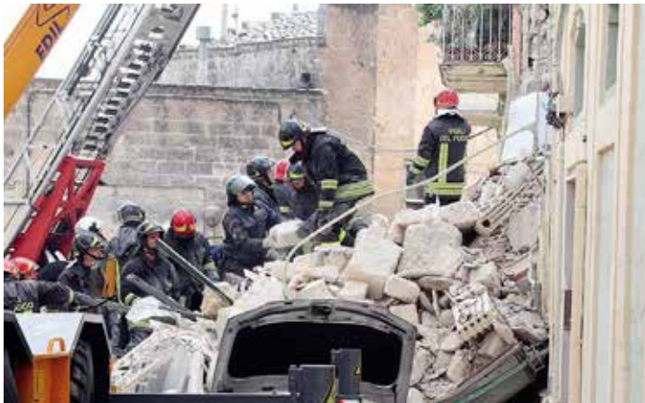
UN GRANDE DRAMMA I vigili del fuoco scavano tra le macerie della palazzina in Vico Piave dove perse la vita Antonella Favale [foto Genovese]
