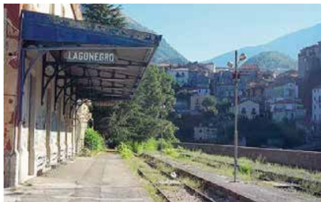
BINARI La stazione di Lagonegro dismessa dal 1987
