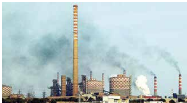
TARANTO Veduta esterna dello stabilimento siderurgico Ilva
