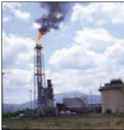
Il centro oli di Viggiano
