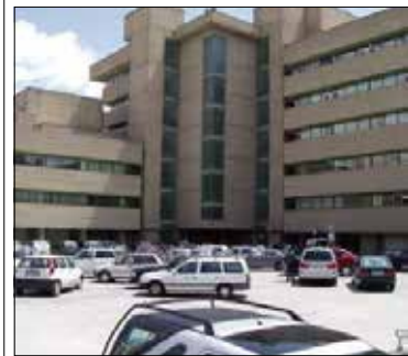
In municipio presso parte del Comando dei vigili urbani
