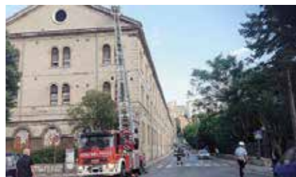
INTERVENTO I vigili del fuoco sul tetto della caserma [foto T. Vecchi]
