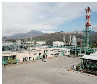
VIGGIANO Il centro di Eni
