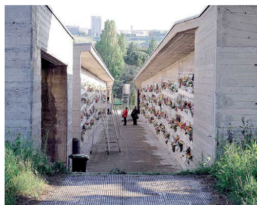
ULTIMA DIMORA Uno scorcio del nuovo cimitero in contrada Pantano
