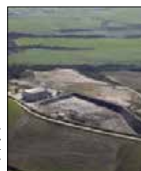
Una delle nuove vasche realizzate alla discarica
