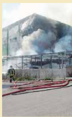
FIAMME Il capannone a fuoco
