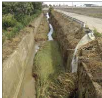
I canali di scolo adiacenti ai campi di pomodoro completamente otturati
