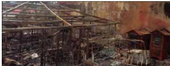
Una parte del capannone distrutto
