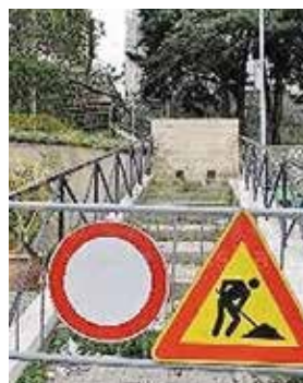
SCALINATA La struttura da riqualificare
