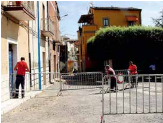
DISSESTO Nella foto d'archivio la frana di rione Casale del 2009
