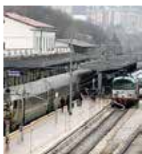
STAZIONE Potenza centrale
