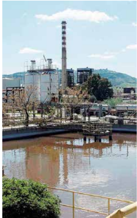
PISTICCI L'impianto di Tecnoparco ubicato a Pisticci Scalo. La polemica è esplosa sui reflui [foto Grieco]
