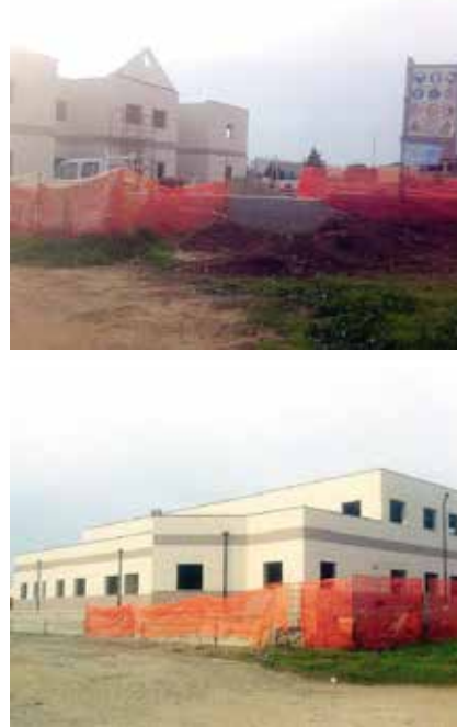
CANTIERE Il commissariato in costruzione [foto Grieco]
