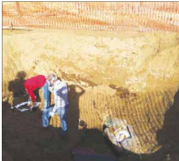
I tecnici all'opera per la riparazione della falla probabilmente dolosa
