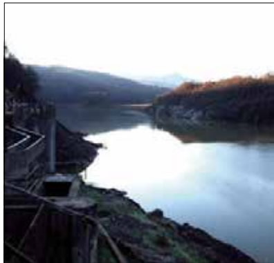
La diga di Muro Lucano
