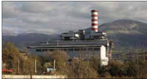
La centrale del Mercure
