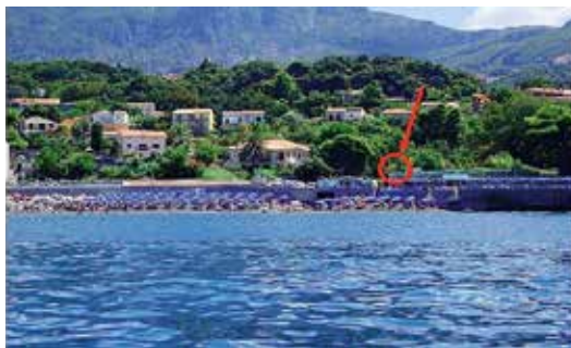
MARATEA La spiaggia di Fiumicello con alle spalle, cerchiato in rosso, il sito della centrale idroelettrica
