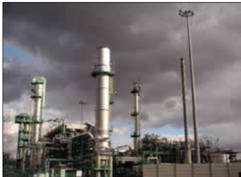
Il Centro Oli di Viggiano
