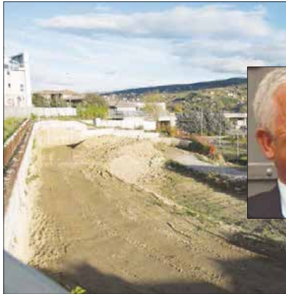
L'area dei lavori accanto al Ponte Musmecì. Nel riquadro Vito Arcasensa
