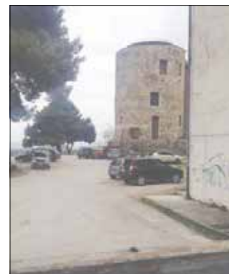
L'interno dell'area della Torre Guevara, gioiello abbandonato
