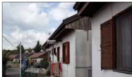
Prefabbricati a Bucaletto
