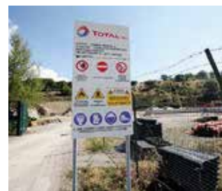
PETROLIO L'impianto di Tempa Rossa
