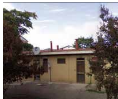
Due strutture con copertura di amianto ad Atella
