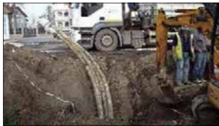
Lavori per impianti telefonici
