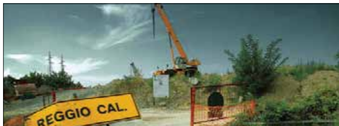
Un cantiere della Salerno Reggio Calabria
