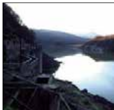
La diga di Muro Lucano
