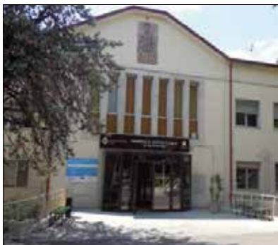
L'ospedale distrettuale di Tricarico
