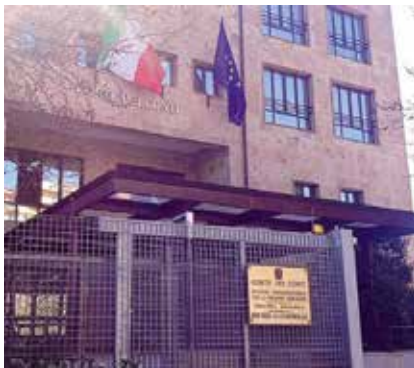
RESTITUZIONE Il palazzo della Corte dei Conti di Potenza
