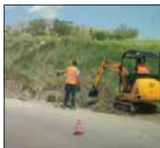
Operai a lavoro sulla strada
