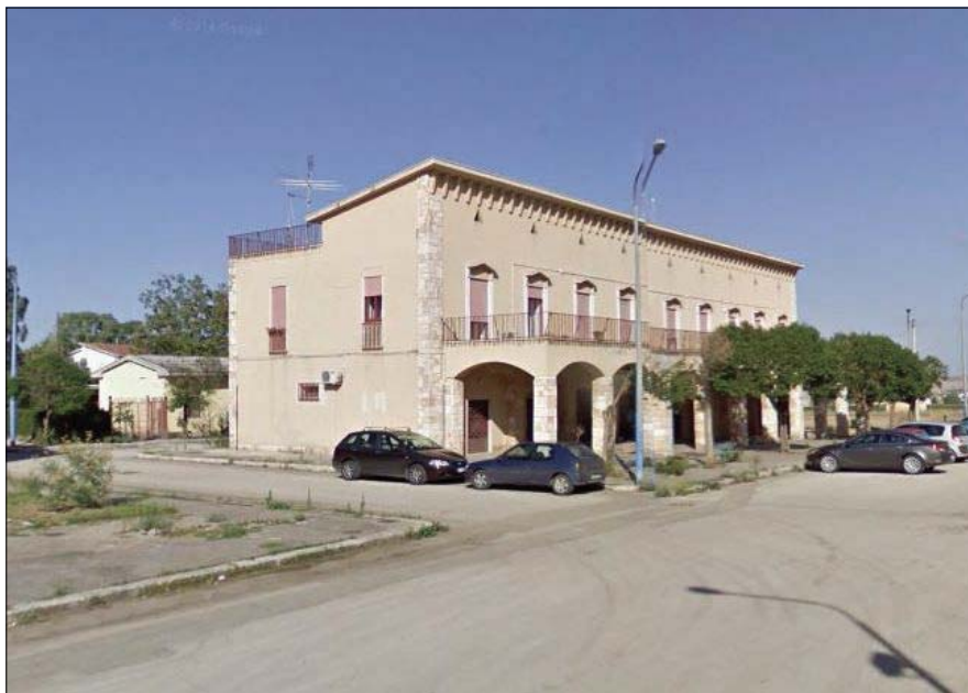
La sede del Consorzio di bonifica Vulture Alto Bradano
