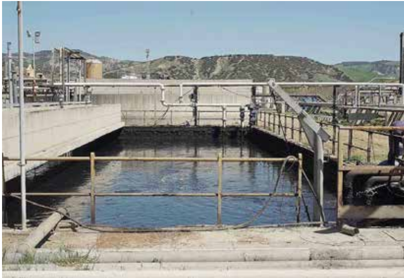
IMPIANTO Una delle vasche di Tecnoparco. Nel riquadro in basso il sindaco Di Trani e l'assessore Leone
