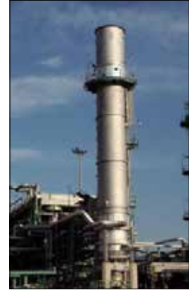
Il Centro Oli di Viggiano
