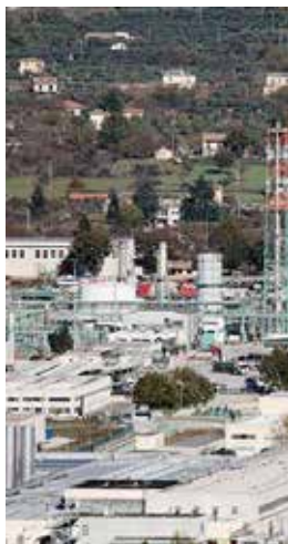
PETROLIO Il Centro Olio dell'Eni in Val d'Agri nell'area industriale di Viggiano [foto Tony Vecce]
