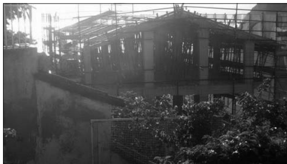
Il "mostro" edificio di via San Francesco dei poverelli. In basso com'era, com'è: la visuale che si poteva vedere da quel punto prima che venisse realizzato il palazzo che ora nasconde completamente il panorama
