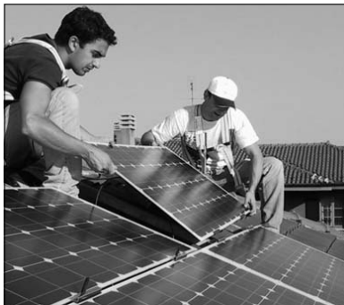
Il montaggio di pannelli fotovoltaici
