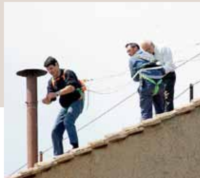
ROMA Operai al lavoro per piazzare il comignolo della «fumata»
