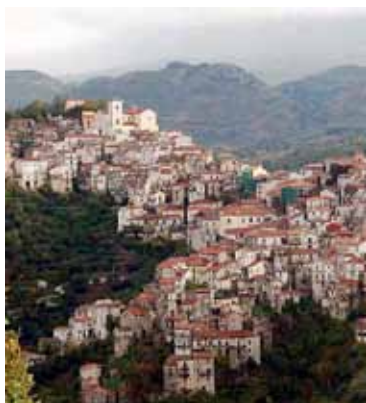
RIVELLO La zona dell'epicentro
