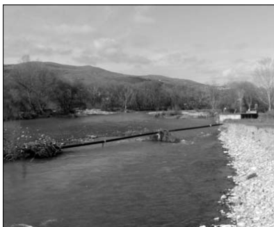
Il tubo dell'Acquedotto Lucano scardinato dai piloni e finito sul letto del fiume Basento ai Giardini di Grassano
