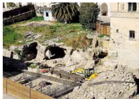
LE GABBIE Pronte per accogliere il cemento all'ex convento di S. Agostino
