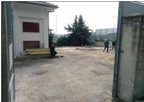
Operai al lavoro ieri mattina a La Martella per l'antenna
