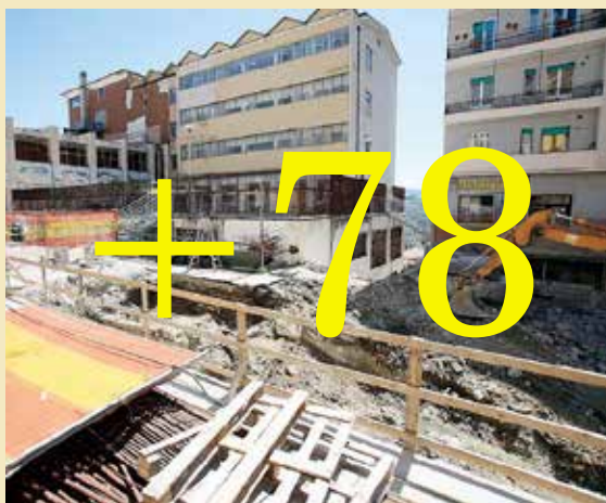
CANTIERE Lavori a rilento. Il Comune ha concesso una proroga [foto Tony Vecce]
