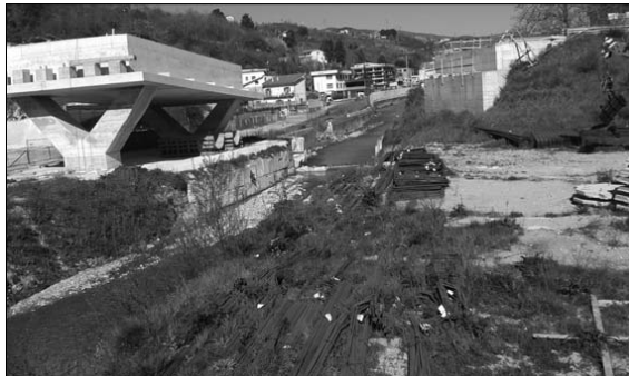
Il cantiere fermo in via del Gallitello
