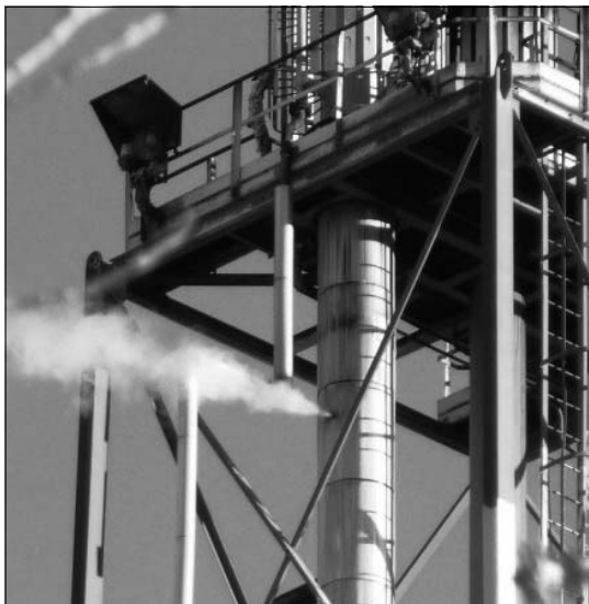
Il foro al centro della torcia da cui esce vapore acqueo
