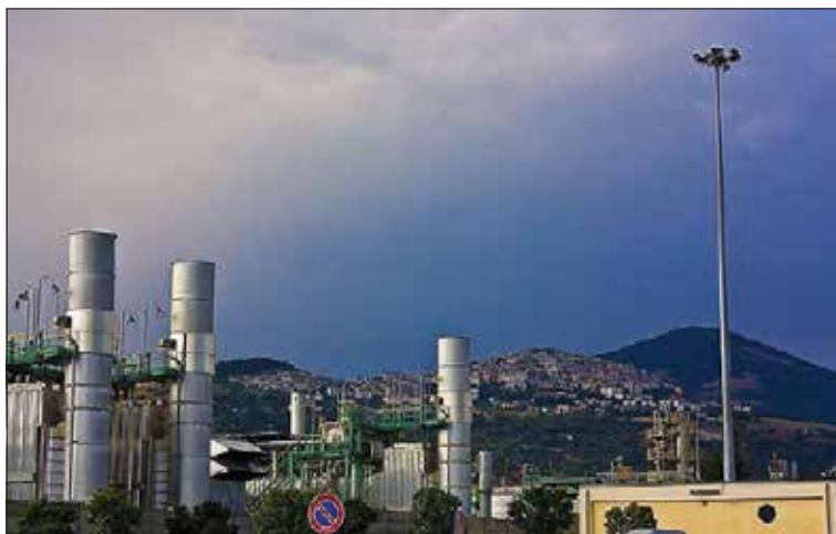
L'area del Centro Oli di Viggiano
