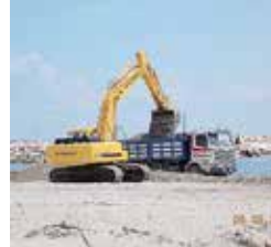
LAVORI Mezzi meccanici in azione
