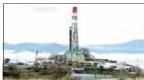
Un pozzo di esplorazione nell'area della concessione Tempa Rossa
