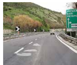
RACCORDO AUTOSTRADALE Potenza-Sicignano
