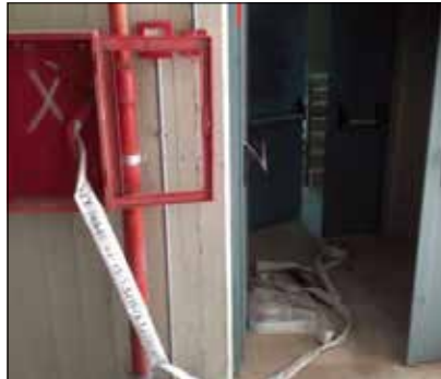
Alcuni dei danni al parcheggio di viale delle Nazioni Unite
