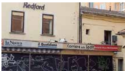
DEGRADO Sacchetti dell'immondizia sul tetto del fabbricato
