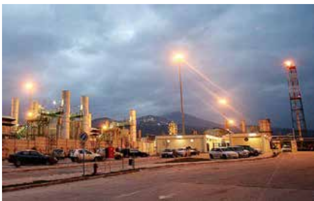
POZZI Il Centro olii di Viggiano (foto Vece)
