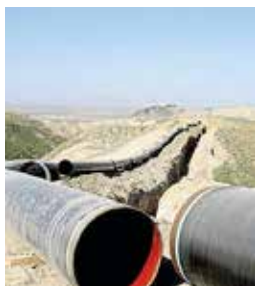
ENERGIA Tubi per il gasdotto
