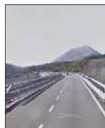
Il viadotto "Le Carre" che dovrà essere demolito dall'Anas
