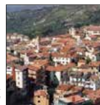
Una vasta area di Vietri si prepara a diventare un cantiere
