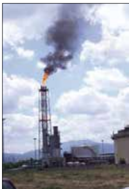
Il Centro oli di Viggiano
