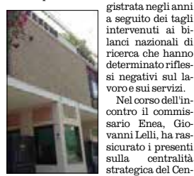
L'Enea di Rotondella
