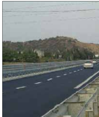
Un tratto della statale 407. Lunedì riapre la galleria di Ferrandina
