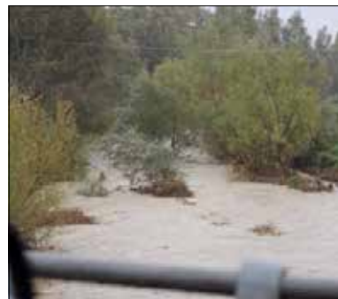
Un canale consortile intasato dalla vegetazione non rimossa
