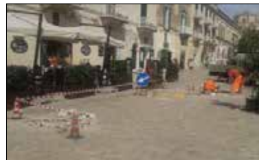
Sono in corso i lavori in piazza Ridola
