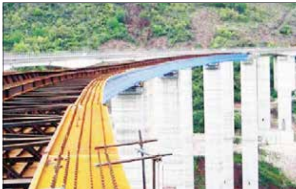
Un cantiere della Salerno-Reggio Calabria
