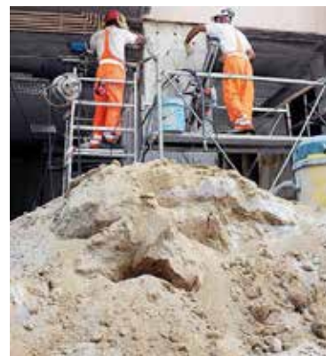
LAVORO Un cantiere edile
