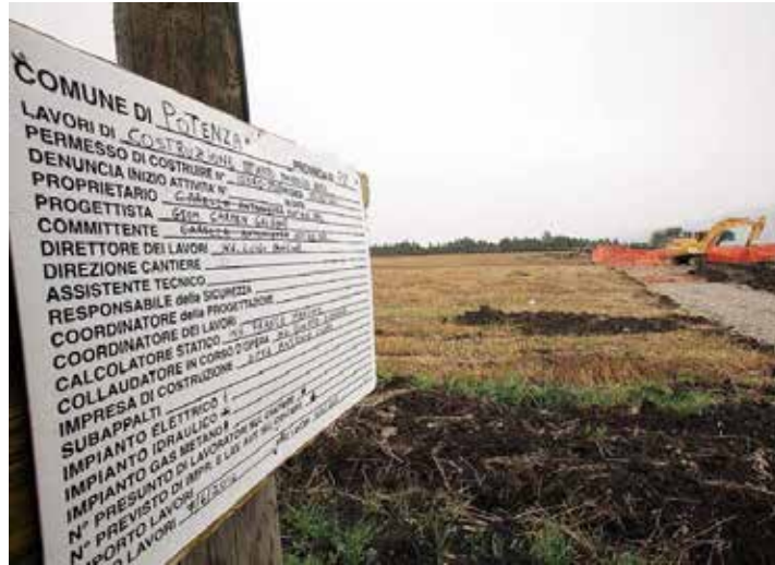
CANTIERE I lavori per la realizzazione di impianti eolici in via delle Matine [foto Tony Vecce]
