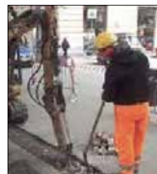
Lavori per le colonnine
