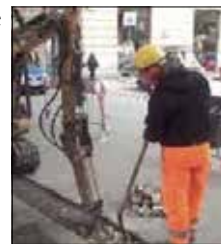
Lavori per le colonnine
