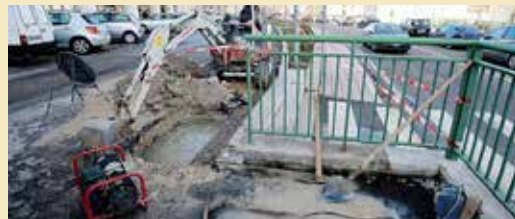
ACQUEDOTTO I lavori di riparazione della perdita in via Cavour [foto Tony Vece]
