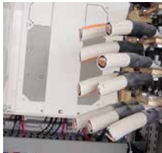
TAGLIO Cavi recisi per strappare il rame
