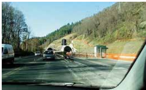
LAVORI OGGI Un tratto in costruzione dell'autostrada Salerno-Reggio Calabria
